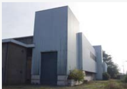
Elektriciteitsstation op voormalig Nuon-terrein: de beplating is inmiddels verwijderd
